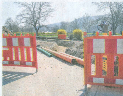
Kein Stopp: Wegen der milden Temperaturen mussten die Arbeiten auf den Baustellen in der Region nicht aufs Eis gelegt werden.
